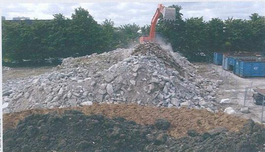
Les gravats issus de la déconstruction du passage à niveau de la rue Étienne-Dolet dans le cadre du chantier Babeuf à Pierrefitte ont servi de matériaux de remblais.
